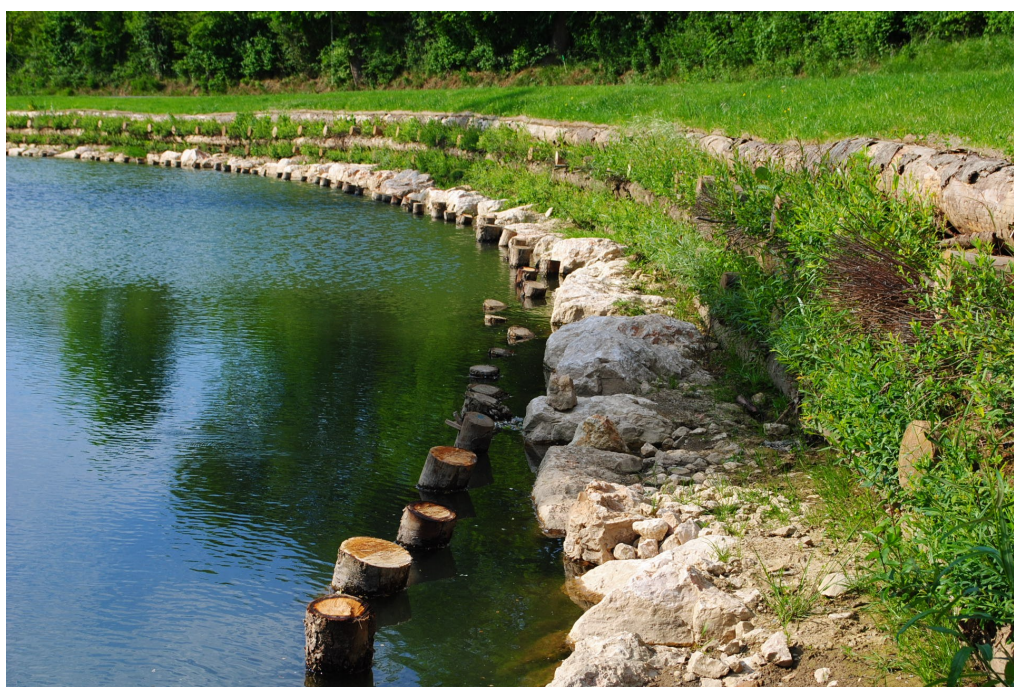
Caissons végétalisés à Daumazan sur Arize
