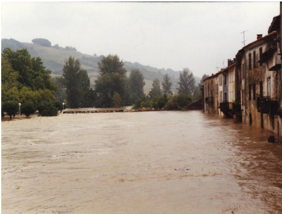
Crue de 2007, les Bordes sur Arize Source : SMIGRA
