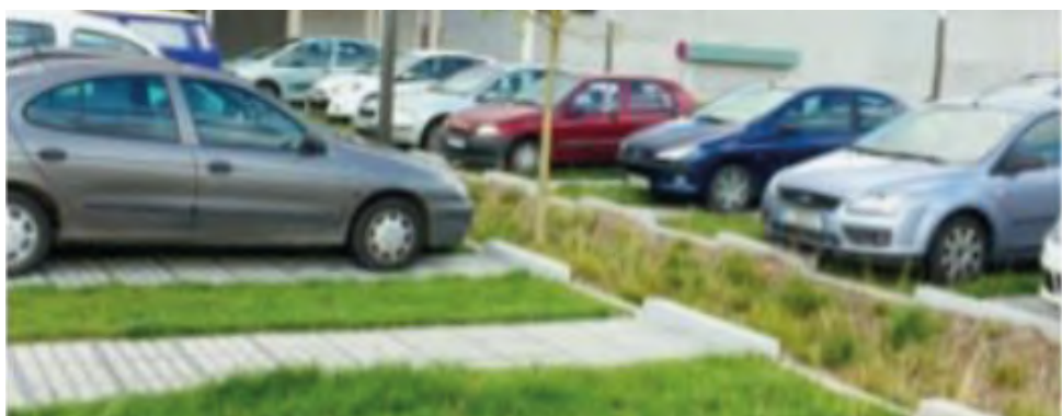
Noue végétalisée avec infiltration gravitaire du ruissellement
