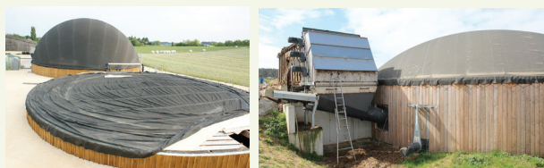
Micro-méthanisation. Le choix du site d'installation d'une unité de méthanisation est décisif pour permettre une intégration respectueuse des paysages qui l'entourent.
