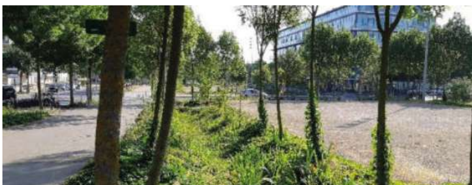
Noue végétalisée et espace semi-perméable
