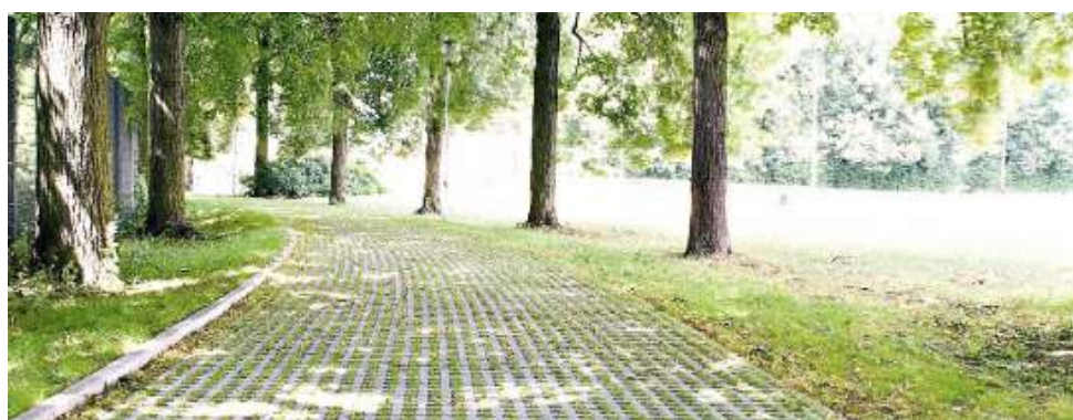
Revêtement de circulation douce semi-perméable
