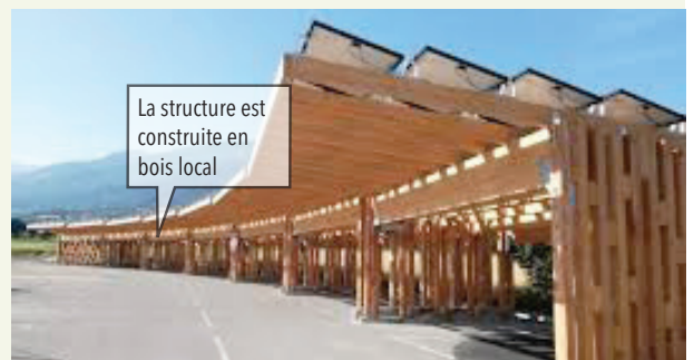
Ombrière photovoltaïque en autoconsommation de Baratier, Hautes-Alpes. SyMÉnergie05
