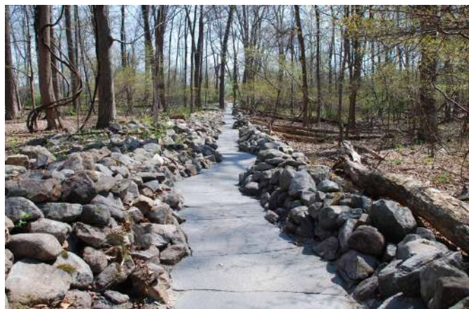
Dalles de béton réutilisées et pierres de site
