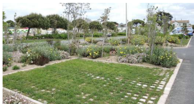
Parking semi-perméable en pavés enherbés, Couarde-sur-Mer
