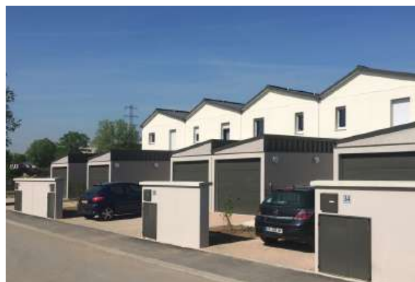
Les murets de clotures intègrent les éléments techniques et peuvent servir de cache-container. ZAC berliet-Saint-Priest (69)
