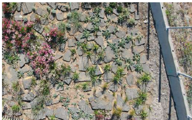
Enrobé découpé en dalles, enherbées
