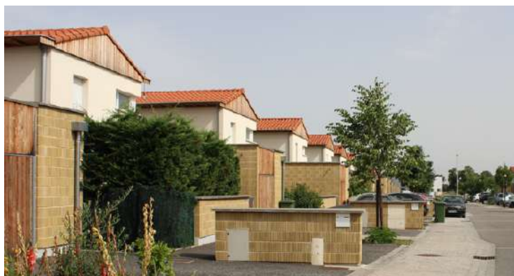
Les éléments techniques ont été intégrés dans des murets assortis aux clôtures et aux garages. Pamiers (09)
